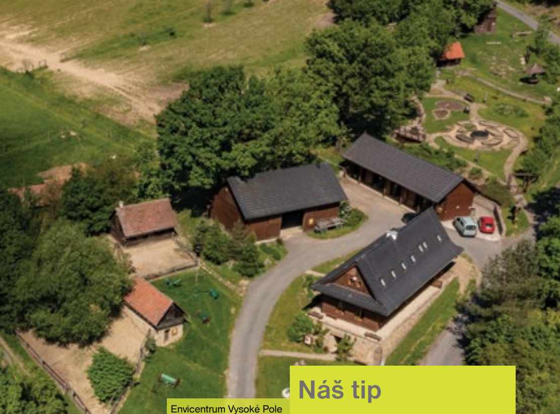
Envicentrum Vysoké Pole
